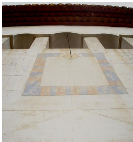
Rellotge de sol i ràfecs en la façana.
