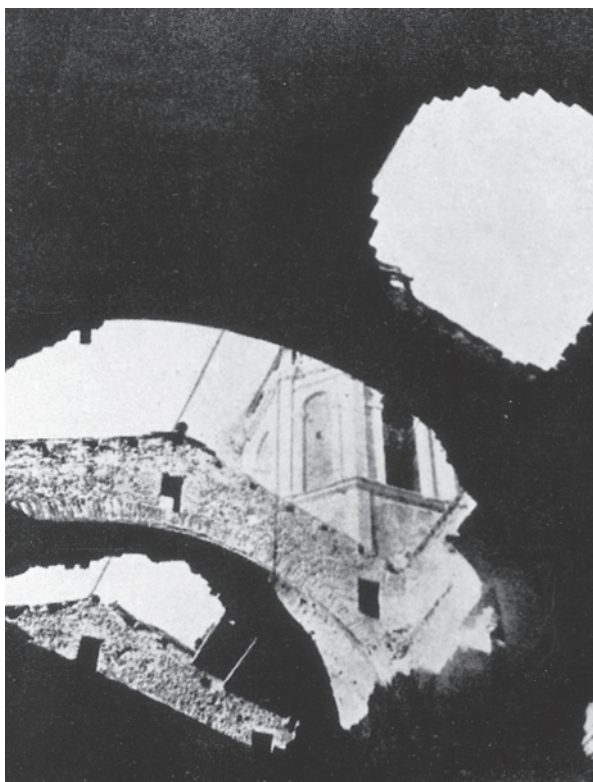
Aquest fou l'estat en que quedà la coberta de l'església en ser presa per les flames.
