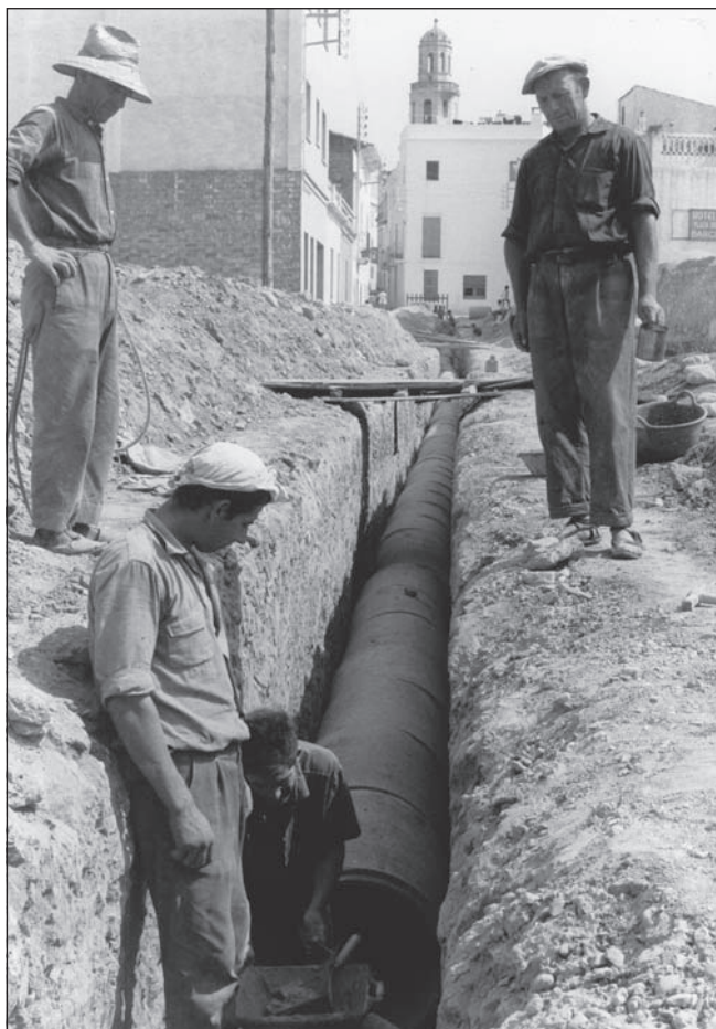
Instal·lació de la xarxa de clavegueram a la part baixa del carrer de Víctor Balaguer, l'any 1964 (Foto AAP)
