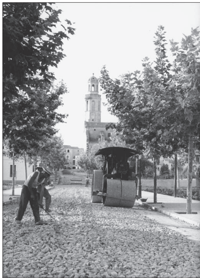
Obres de pavimentació de la Rambla, l'any 1961 (Foto: Arxiu Josep M. Gromaches)
