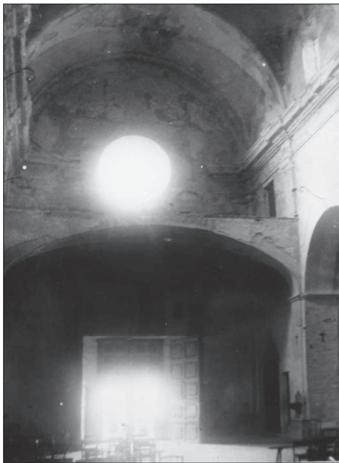
Vista interior de l'entrada de l'església i del cor abans de la reconstrucció (Foto: Arxiu Arquebisbat de Barcelona)
