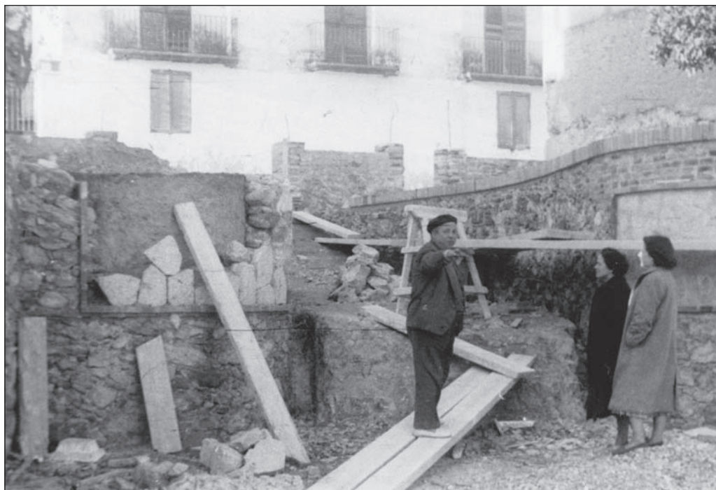
Joan Albet, l'any 1951, durant la construcció d'escales en el carrer del Dr. Estapé (Foto:AAP)
